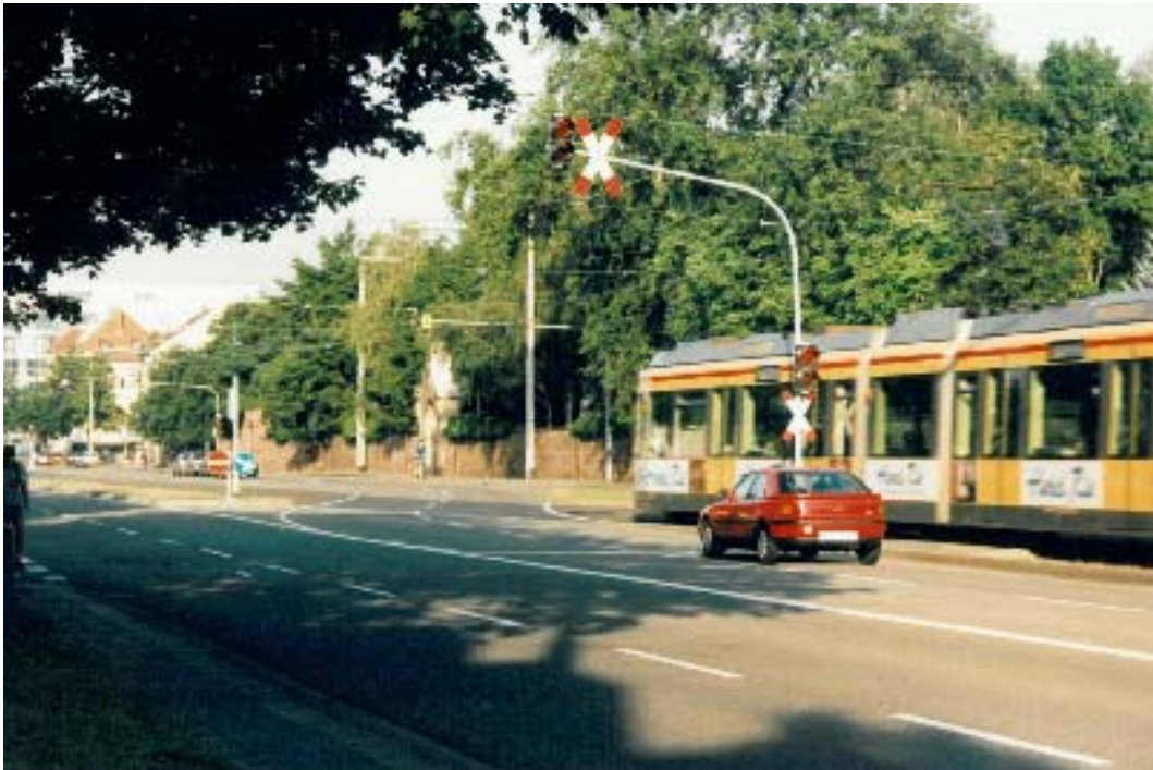
Foto 1: Gleis- bzw. Fahrspurverziehung mit geregelter EK.
